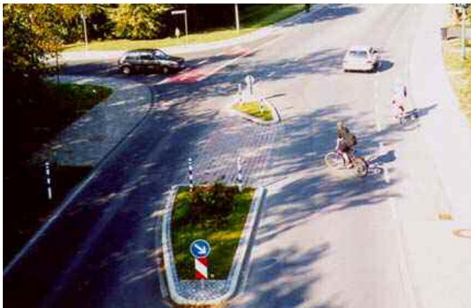
Abb. 3: Mittelinsel als Querungshilfe an einem Ortseingang
