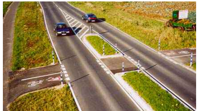
Abb. 2: Mittelinsel als Querungshilfe außerorts
