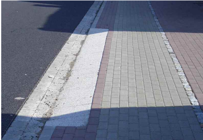
Abb. 8: Radwegüberfahrt in Soltau
