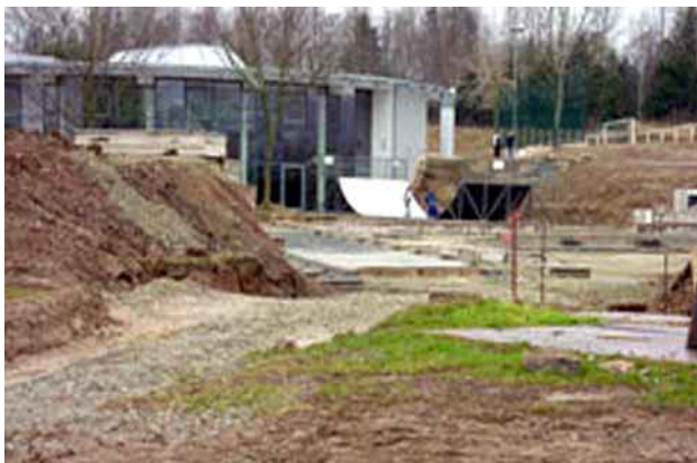
Das Jugendzentrum Leinefelde im Bau. Foto: Weeber + Partner
