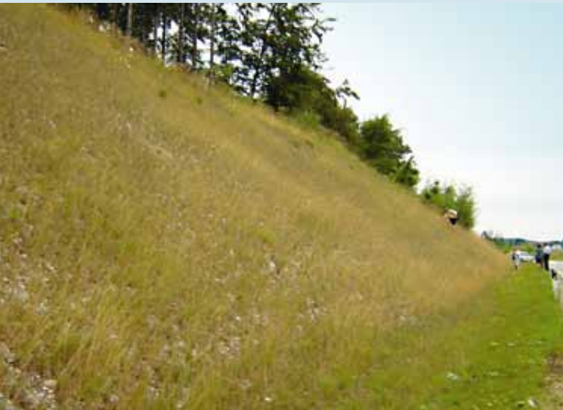
Straßenböschung: Begrünung mit Regelsaatgutmischung; entstanden ist eine zwar erosionsichere, aber artenarme Böschung; nur eine Grasart hat sich durchgesetzt und die Verzahnung fehlt
