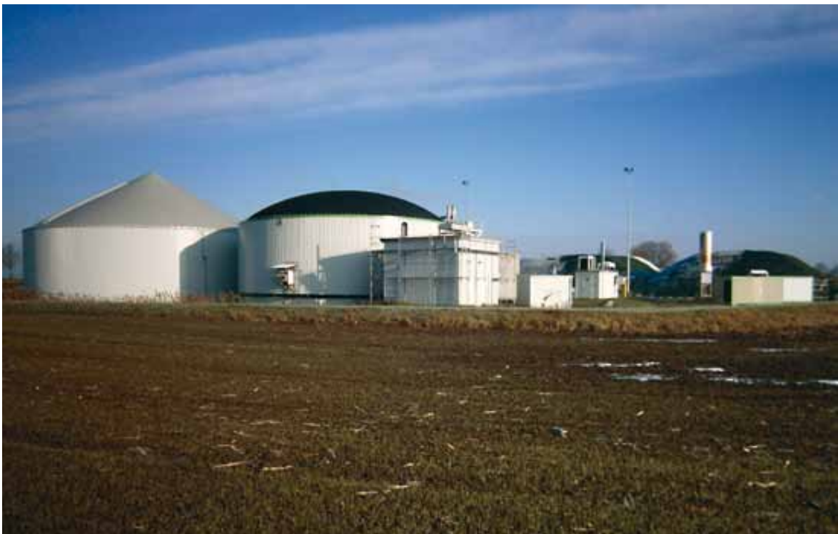
Biogasanlage mit Winterbegrünung nach Mais und Pflanzenkläranlage
