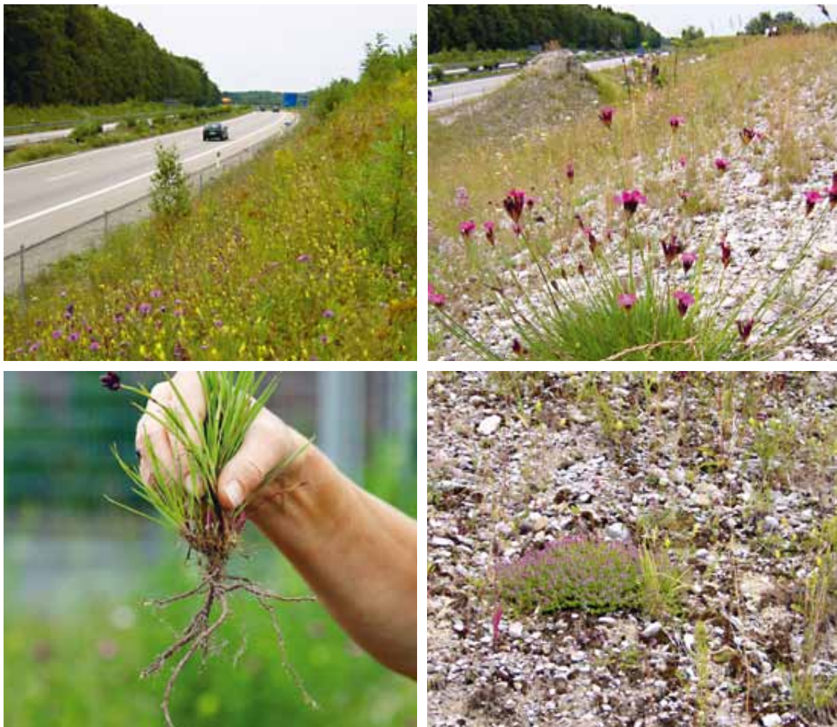
Straßenböschung: Begrünung im Heudruschverfahren – entstanden ist eine erosionssichere, artenreiche Böschung (o. li.); Detail mit Kartäusernelke ( Dianthus carthusianorum ) im Vordergrund (o. re.); Kartäusernelke, ausgegraben als ganze Pflanze: derbe drahtige Wurzeln, die sich insbesondere im Steingrus gut verankern und mit feinen Graswurzeln zusammen ein Gerüst bilden (u. li.); Detail mit Thymian ( Thymus serpyllum ) im Vordergrund – der kleine Zwergstrauch deckt ganze Bodenpartien ab und bildet mit Moosen und anderen Arten einen guten Erosionsschutz (u. re.)
