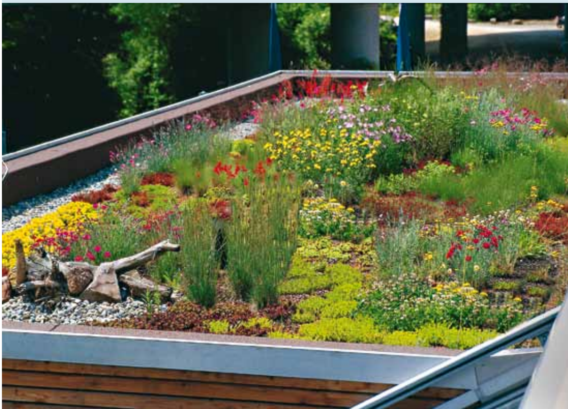
Extensive Dachbegrünungen können bei entsprechender Gestaltung eigenständige Ökosysteme bilden
