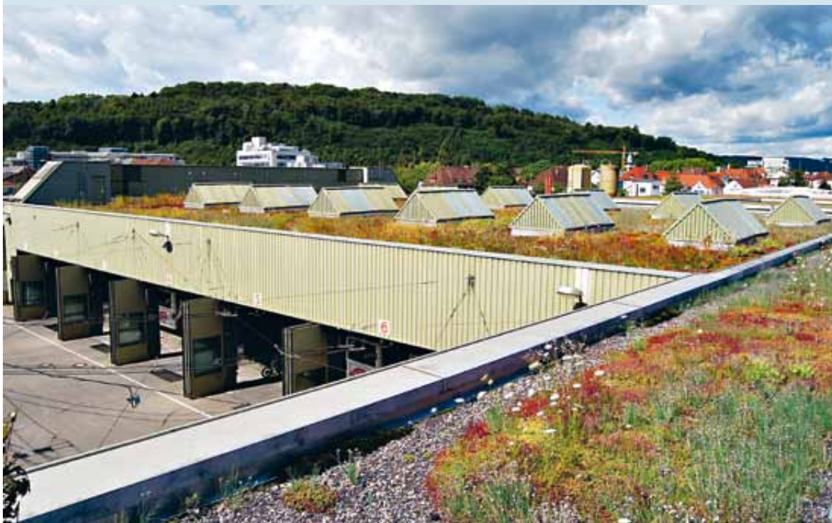
Industrieunternehmen können mit begrünten Dächern gezielt die Umweltsituation am Standort verbessern
