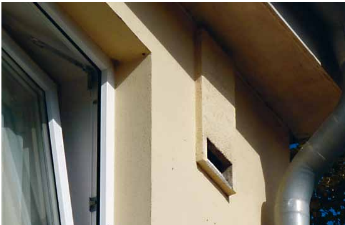
In die Fassade eines sanierten Gebäudes integrierter Fledermausziegel
