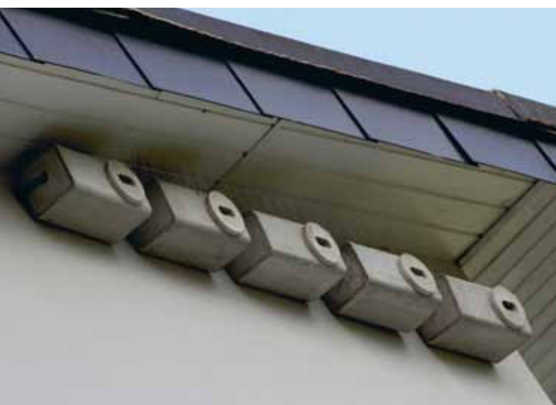
Einflugschlitz und Nisthöhlen für Mauersegler in sanierten Gebäuden
