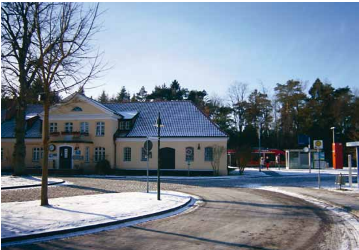
Energetisch sanierter und wiedereröffneter Bahnhof Pansdorf
